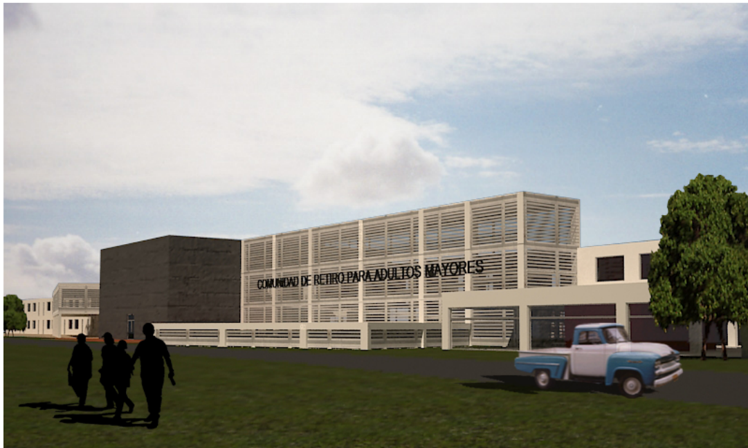
FOTO 38: VISTA DESDE LA FACHADA DE INGRESO AL PROYECTO
