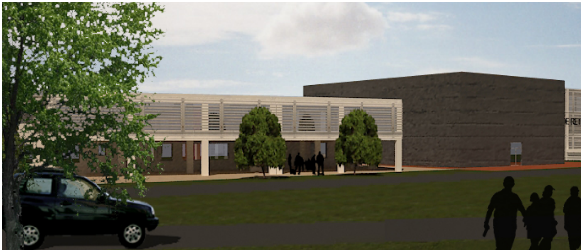
FOTOGRAFÍA 34: VISTA DEL BLOQUE 4. CONSULTORIOS MÉDICOS
