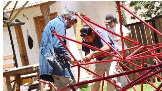
Figura 28: Armado de la vivienda
