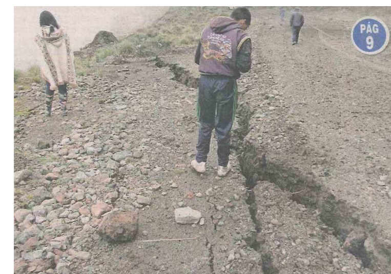
Figura 22:Grietas en vías
