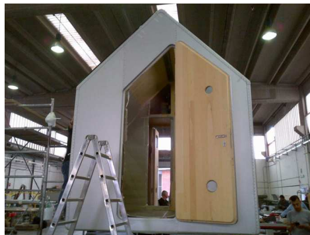
Figura 32: Construcción de la vivienda
