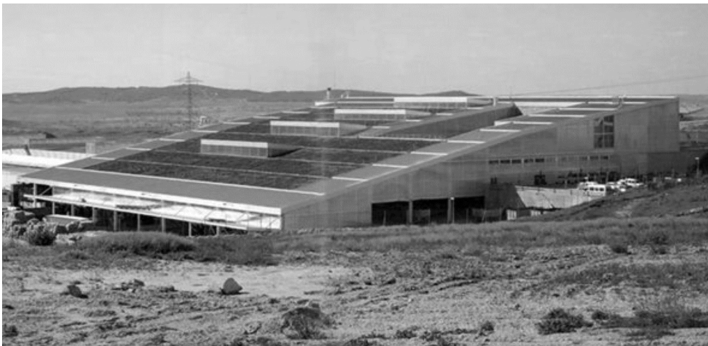
Figura 37: Vista exterior planta de reciclaje Valdemingómez. Fuente: Estudio Herreros, Link: http://estudioherreros.com/es/project/planta-de-reciclaje/
