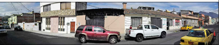
FACHADA EXISTENTE, CALLE LÉRIDA
