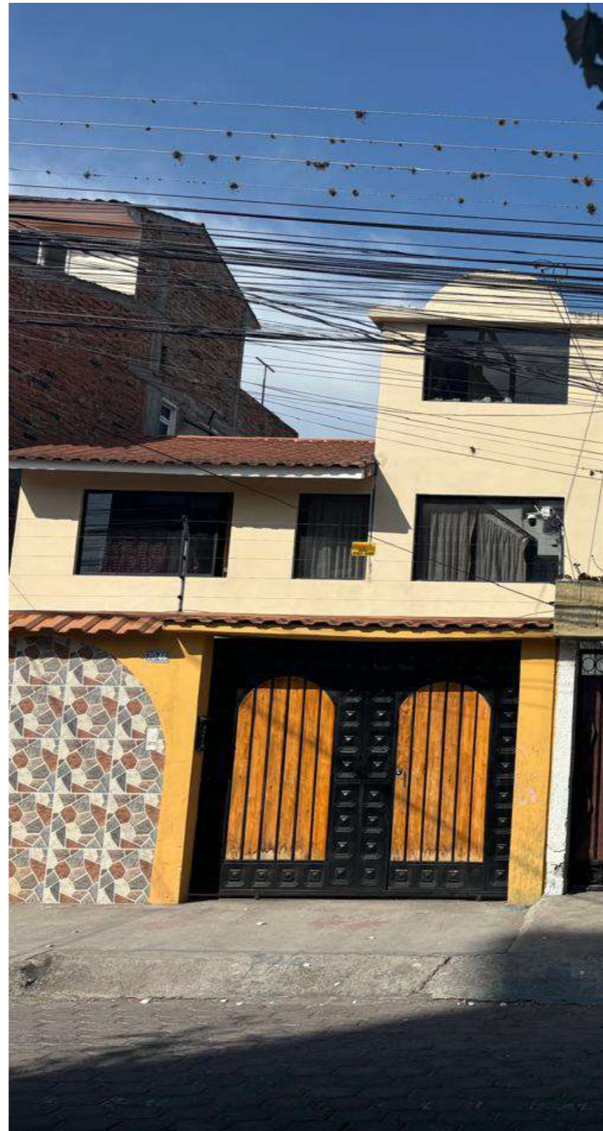
Fig. 97, Casa de vía colindante. Fuente: Elaboración propia.
