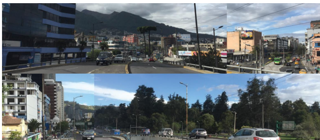
Figura 26. Vista Occidental y Oriental sobre el Puente del Guambra.
