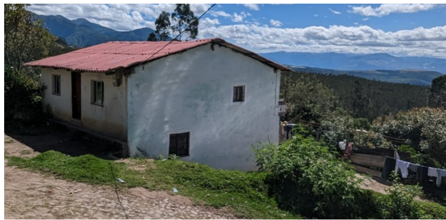
Figura 78. Edificación de dos pisos
