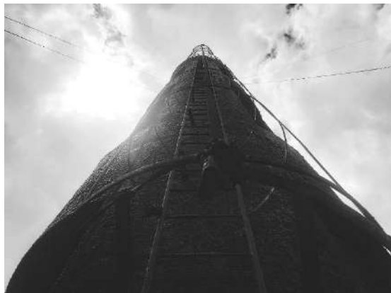
Imagen 42. Vista inferior lateral del silo de hormigón armado
