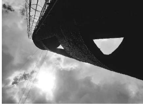
Imagen 41. Vista inferior lateral del silo de hormigón armado
