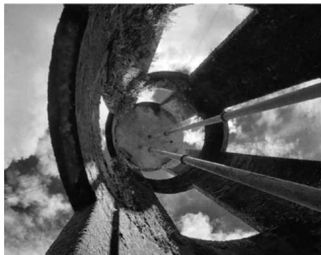
Imagen 40. Vista inferior del silo de hormigón armado
