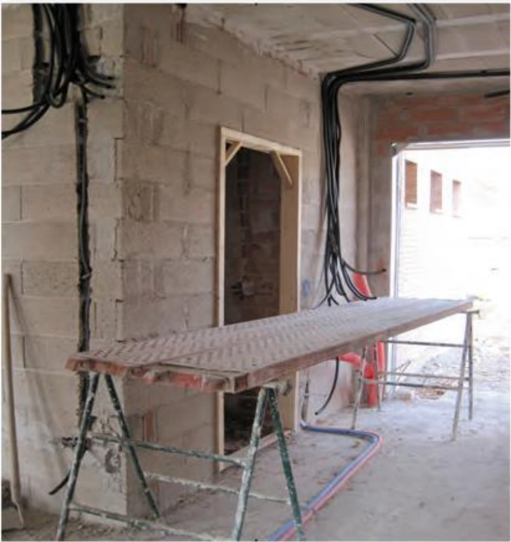
ANEXOS 5 INSTALACIÓN DE ANDAMIOS TIPO CABALLETE
