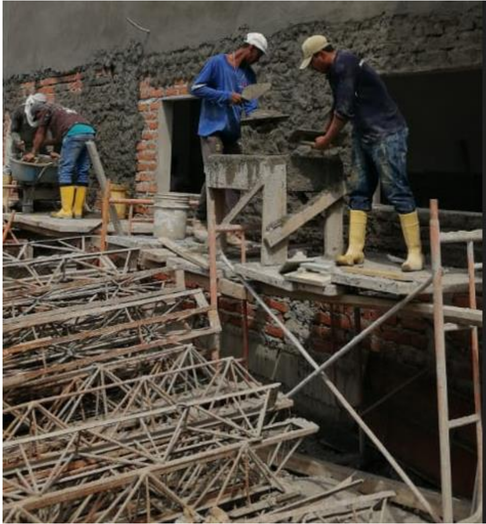
ANEXOS 2 TRABAJOS DE ENLUCIDOS CON AYUDA DE ANDAMIOS.
