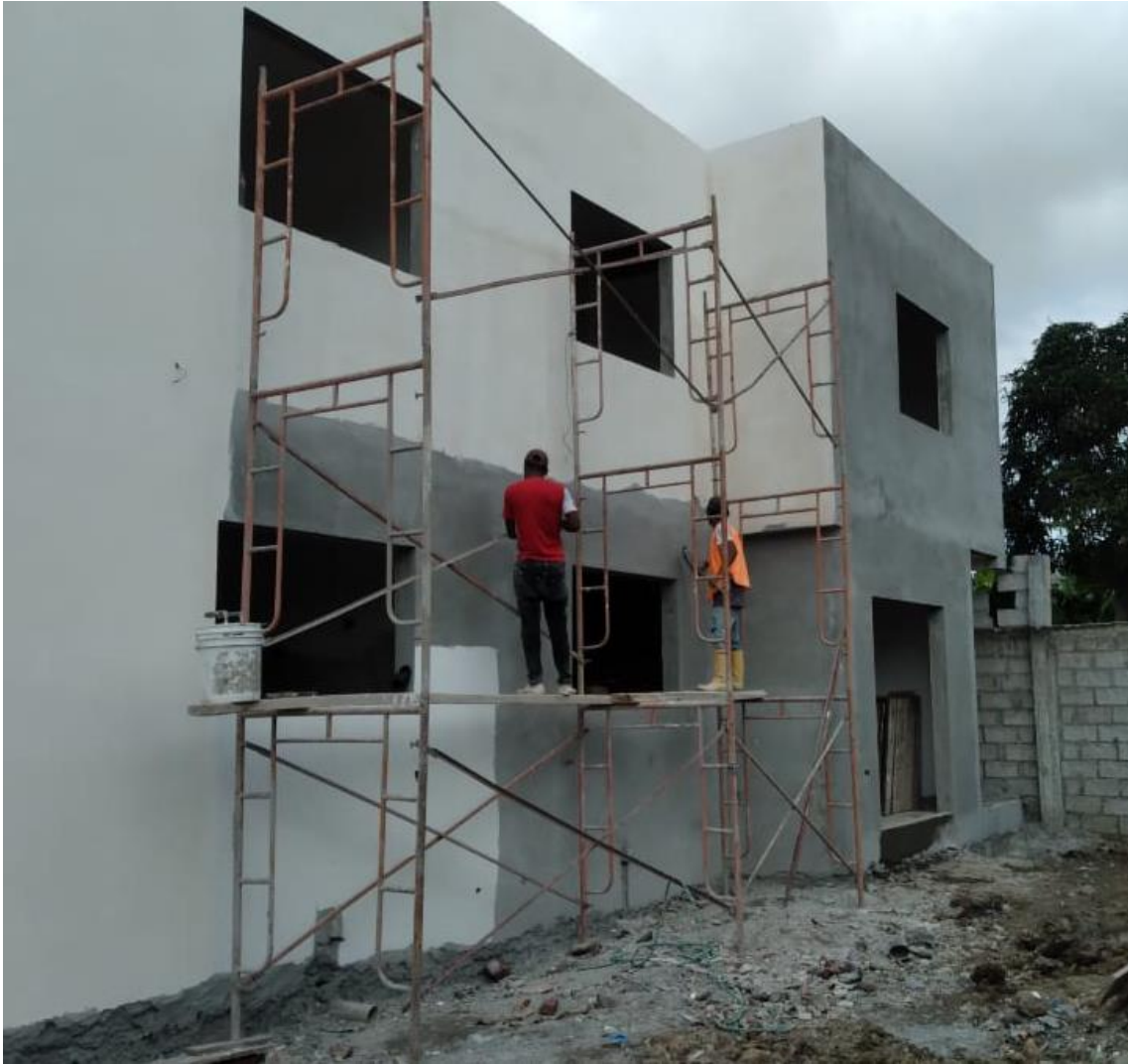
ANEXOS 4 INSTALACIÓN DE ANDAMIOS PARA REALIZAR ENLUCIDOS
