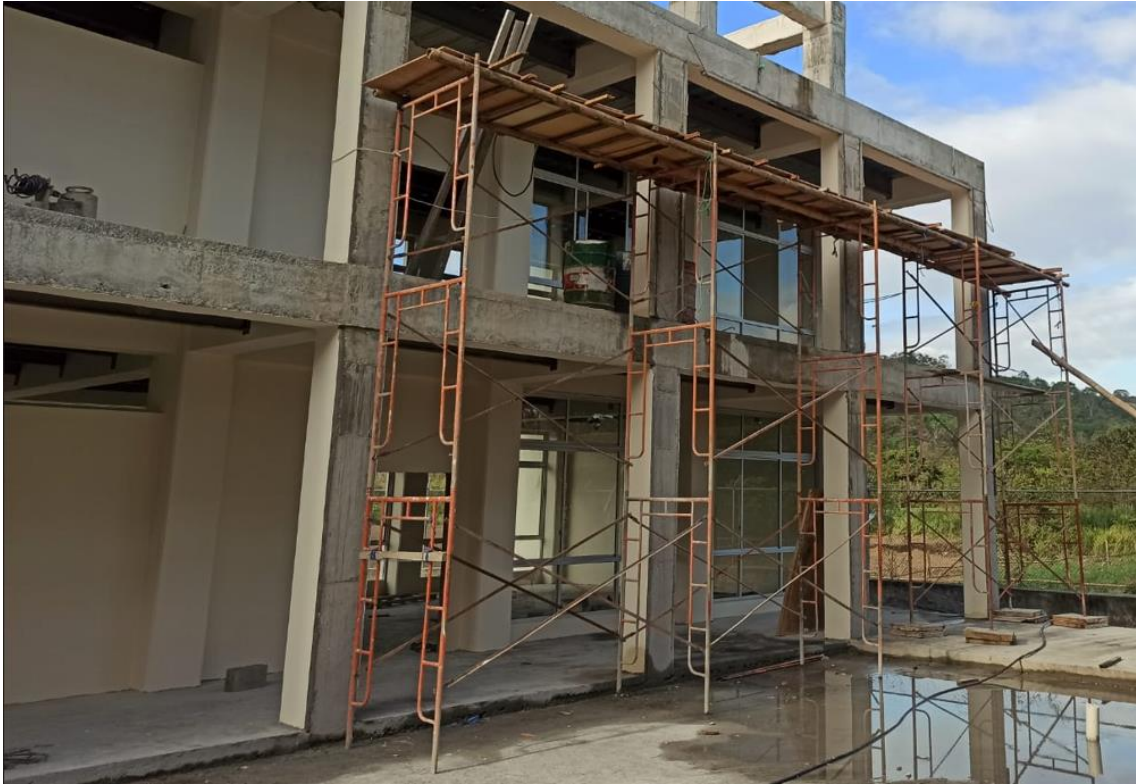
ANEXOS 3 INSTALACIÓN DE ANDAMIOS
