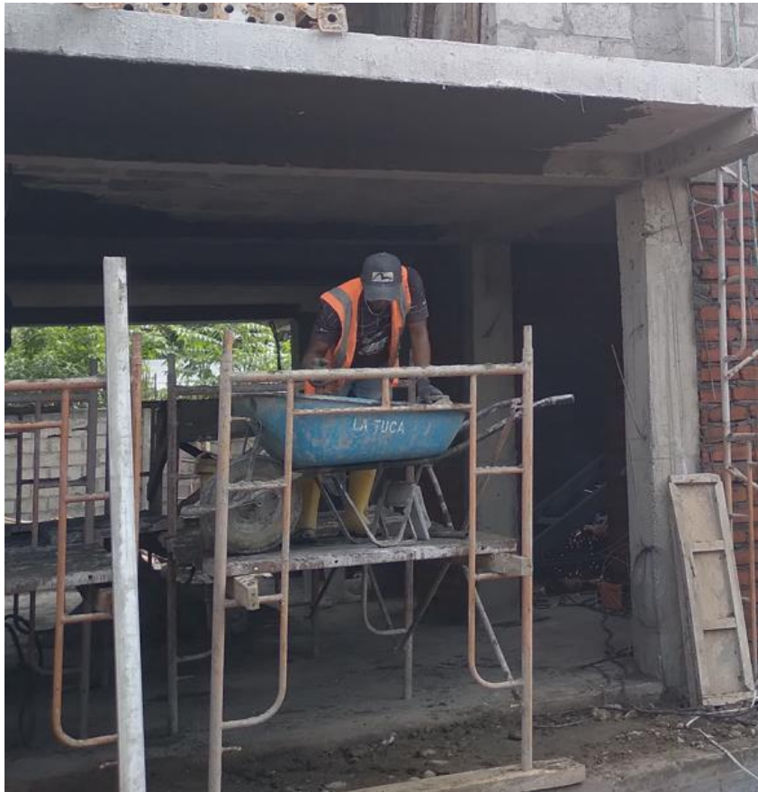
ANEXOS 1 ELABORACIÓN DE MEZCLA PARA REALIZAR ENLUCIDO SOBRE ANDAMIO
