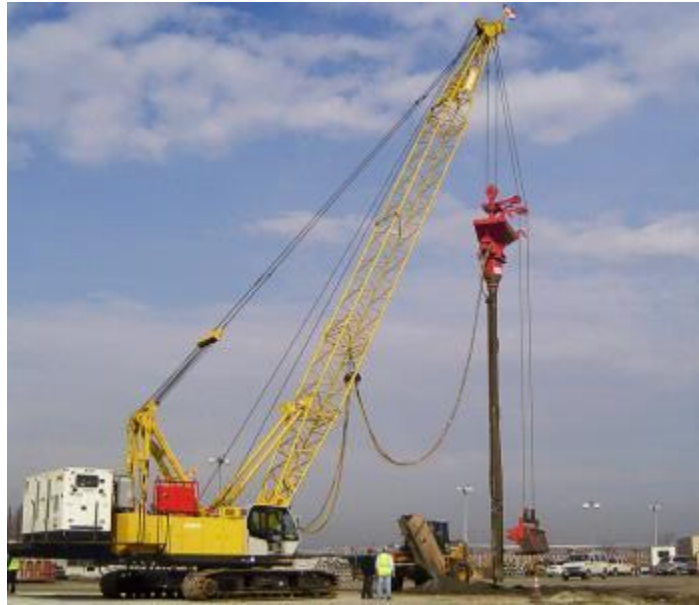
Figura 2.4: Equipo de Vibro flotación.
