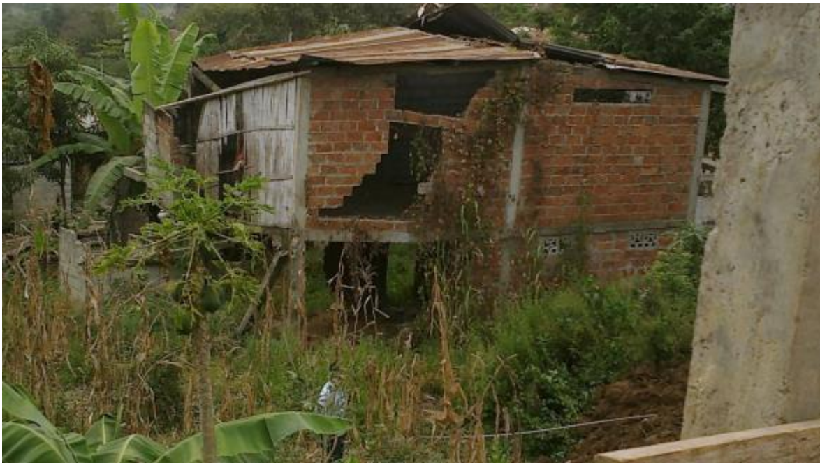
Figura 1.5: Levantamientos en las estructuras del sector Calcical.
