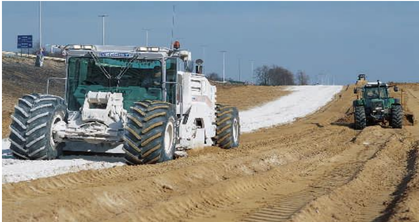
Figura 2.6: Mezcla de cal por vía seca.
