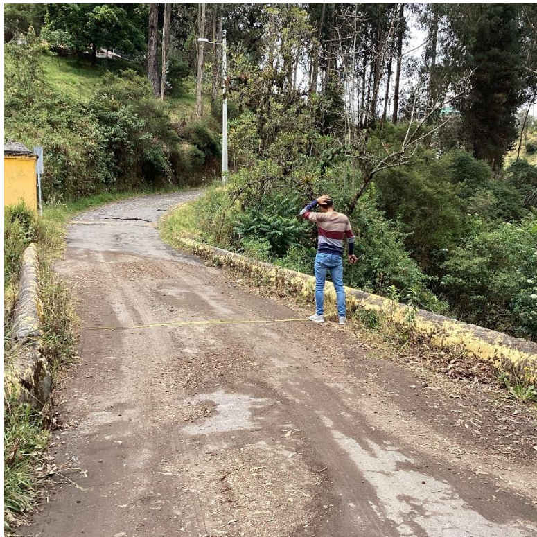
Ilustración 34: Medición de ancho de superficie de rodadura en puente (Fuente propia)
