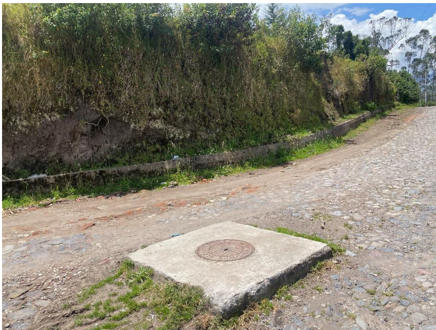
Ilustración 32: Pozo de revisión sobre el nivel normal de la vía. (Fuente propia)
