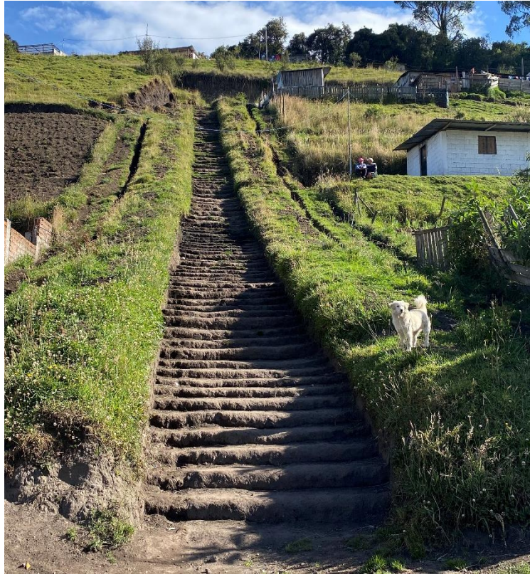
Ilustración 29: No existe vía, únicamente escalinata de acceso (Fuente propia).
