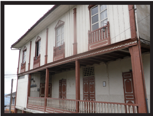
Arquitectura Parroquia Zaruma
