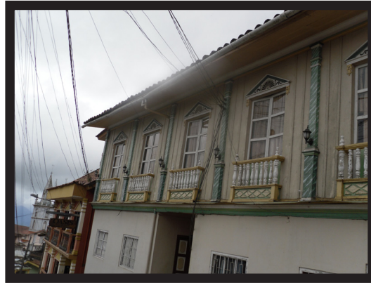
Arquitectura Parroquia Zaruma
