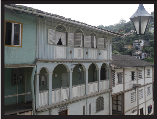
Arquitectura Parroquia Zaruma
