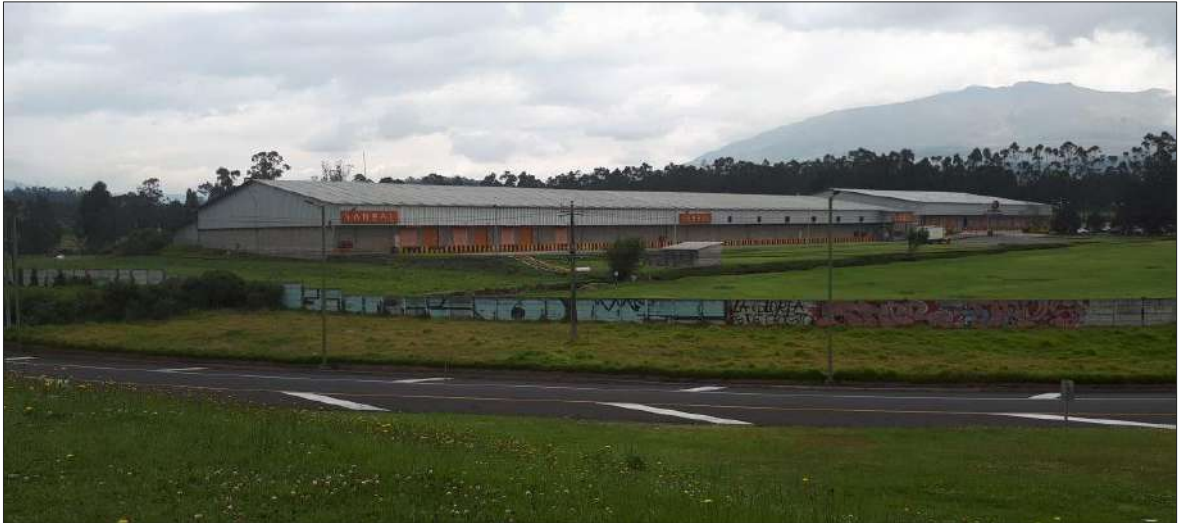
Fotografía 5 Planta de distribución Yanbal, parroquia de Alóag
