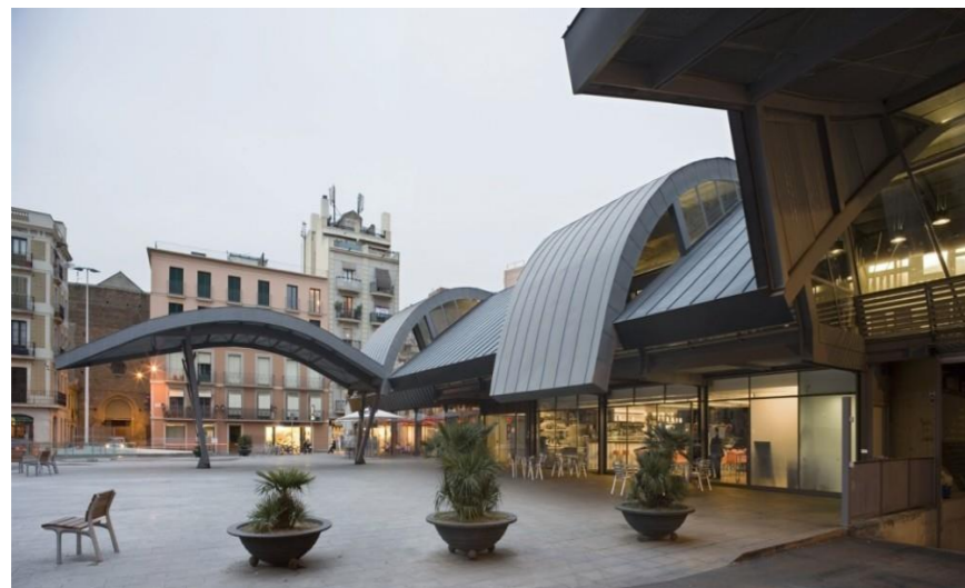
Figura 47: Instalaciones y materialidad. Fuente: Sitio web: (Plataforma Arquitectura 2007.)
