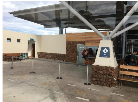
Ilustración 67. Exterior del aeropuerto.
