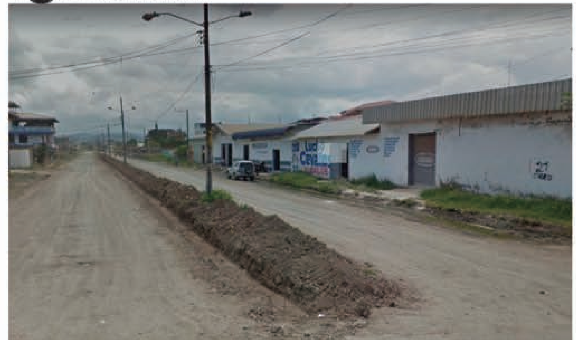
4 Vía lastre -tierra No alcantarillada
