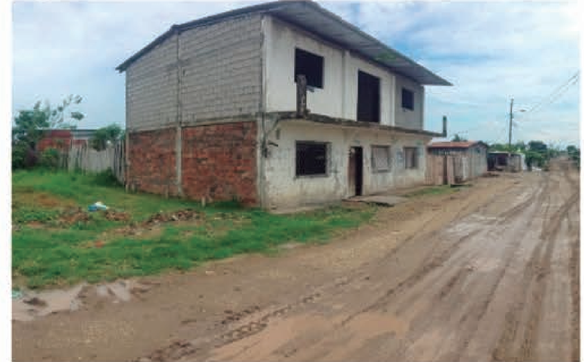
2 Vía lastre -tierra No alcantarillada
