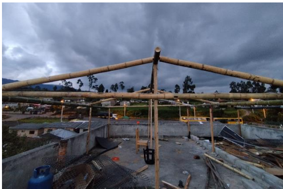
Fotografía 1. Construcción del galpón
