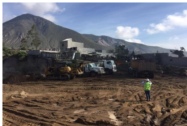
Fotografía 13: Maquinaria en la escombrera
