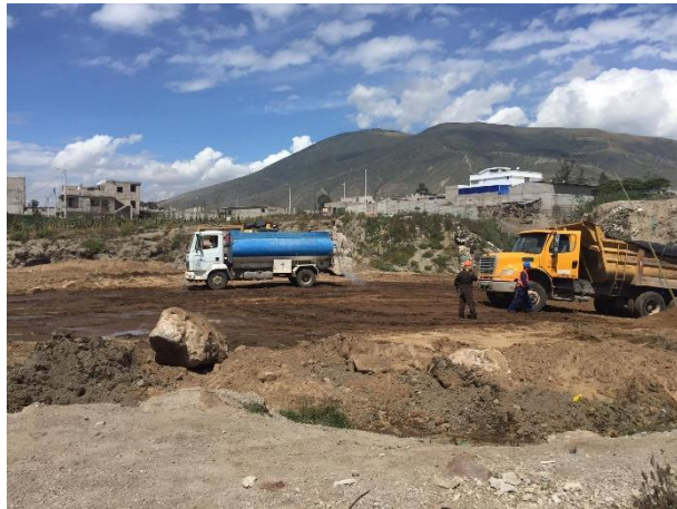
Fotografía 6: Humedecimiento con tanquero de agua
