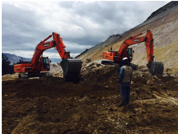
Fotografía 10: Supervisor de excavación
