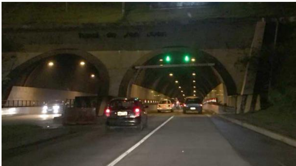
Figura 10 Túnel de San Juan. Fuente Propia
