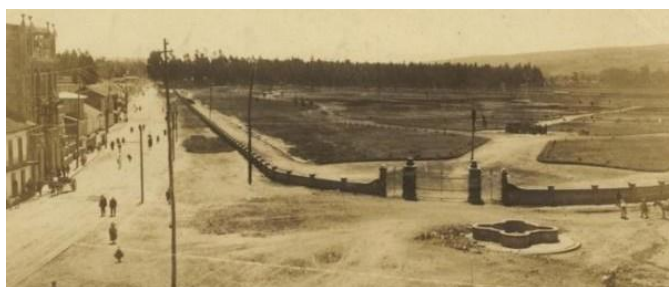
Imagen 5. Parque El Ejido, año 1922. (Los Ladrillos de Quito, 2016).
