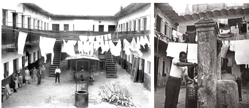
Imagen 10. Conventillo Mediomundo ubicado en Montevideo. (Fotogalería Parque Rodó Arquitecturas Ausentes, 2016)
