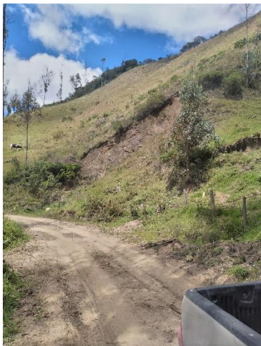
Talud intervenido estable
