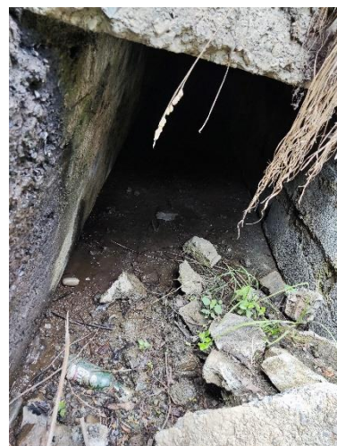
Cajón de hormigón en buen estado
