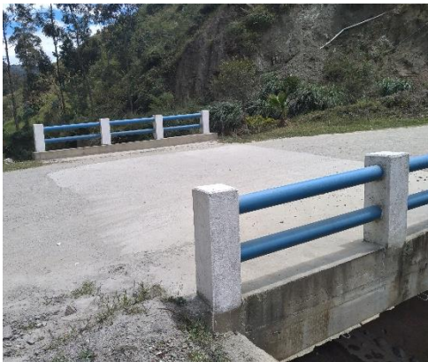
Protección lateral mixta en buen estado
