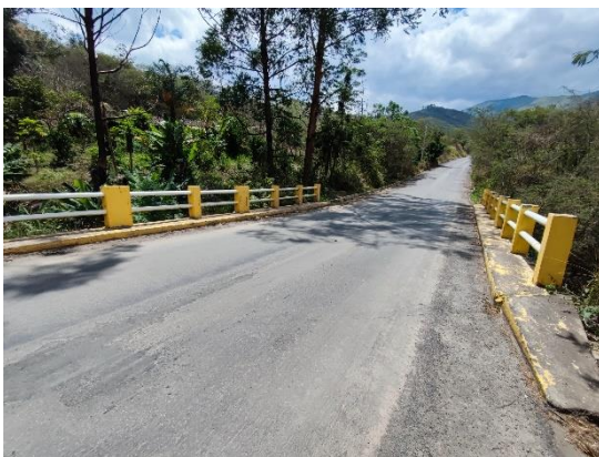
Superestructura del puente en buen estado
