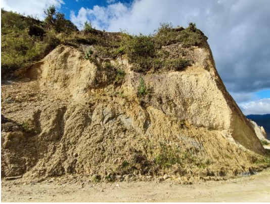
Talud natural estable
