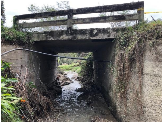
Infraestructura del puente en buen estado
