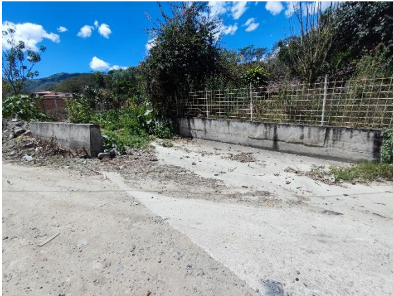
Badén en buen estado
