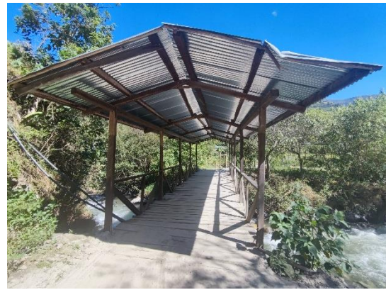
Puente completamente de madera en buen estado
