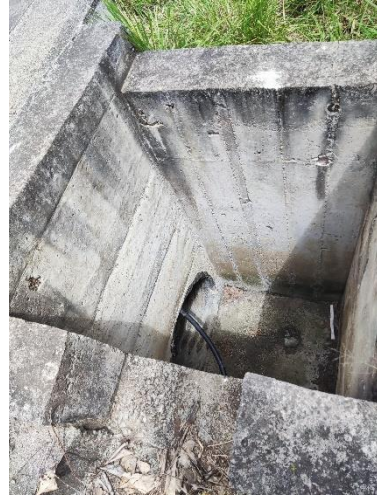
Cabezal tipo cajón en buen estado
