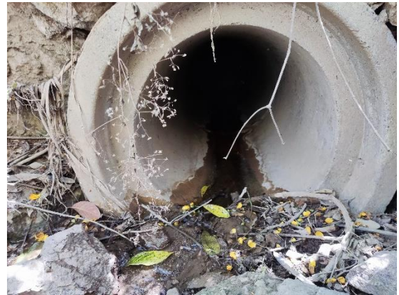
Circular de hormigón en buen estado
