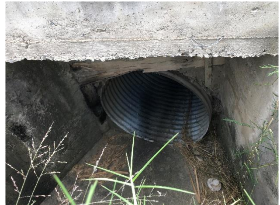
Circular metálica en buen estado
