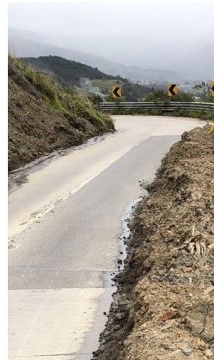
Pavimento rígido bueno
