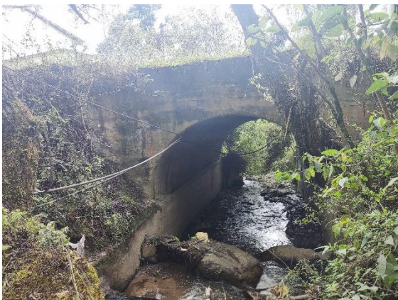
Bóveda de hormigón en buen estado
