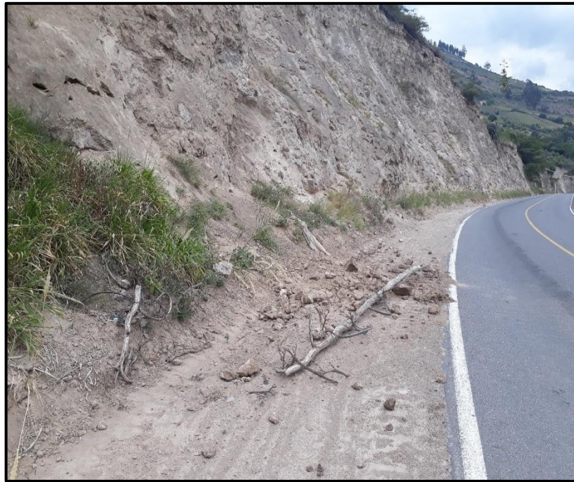
Figura 38. Deslizamiento #15 en la Vía del sector Paridero
