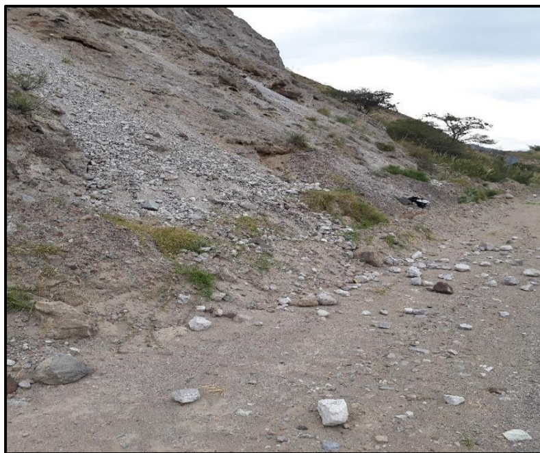
Figura 36. Deslizamiento #3 en Vía Mascarilla
