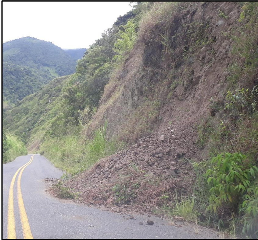
Figura 44. Deslizamiento #100 Vía del sector Gualchán / Espejo 1
