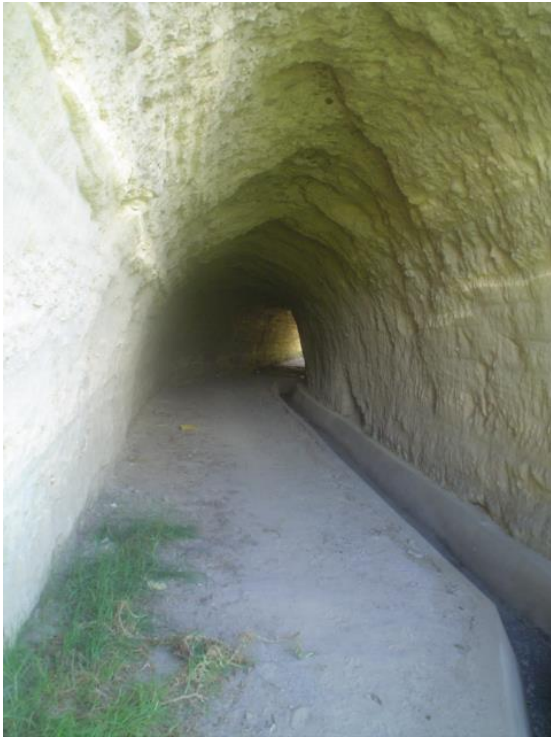
Fotografía 6 Antiguo túnel de ingreso
