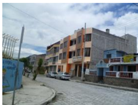
Fotografía 19 Construcción de primer orden
