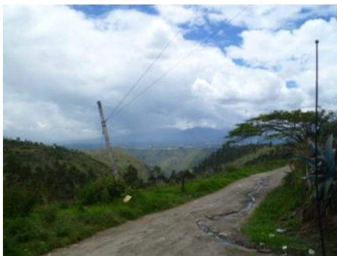
Fotografía 5 Estado de vías y ausencia de alcantarillado en Cocotog
