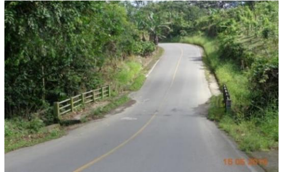
Ilustración 3-14. Cunetas con vegetación, Abscisa 9+280
