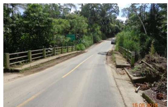
Ilustración 3-12. Cunetas lado derecho e izquierdo, Abscisa 7+50
