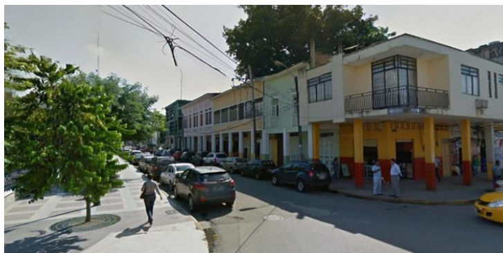
Figura 26. Casas patrimoniales, parte de la arquitectura de la urbe Centro de la ciudad. Calle Simón Bolívar. Referencia Google Earth (2017)
