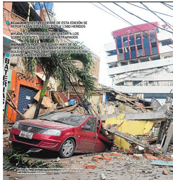
Figura 34. Destrucción en Portoviejo. El Diario Manabita Lunes 18 de abril del 2016, en la ciudad de Portoviejo, Ciudad de los Reales Tamarindo bajo los escombros del 16A. Destrucción en Portoviejo. Referencia https://issuu.com/eldiarioec/docs/lunes_18
