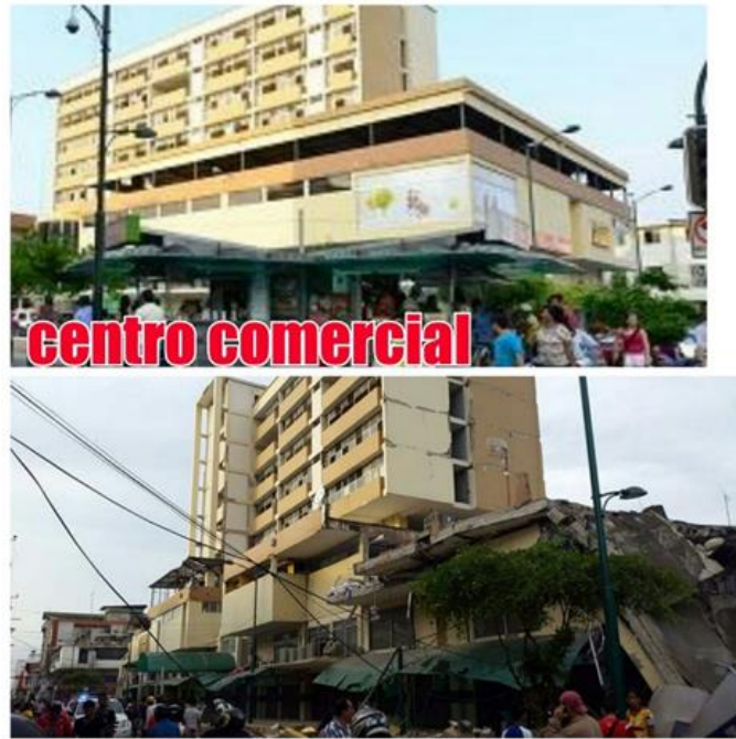
Figura 52. Centro Comercial Municipal antes Mercado Norte antes y después del Terremoto Ubicado en la calle Pedro Gual, calle Chile, calle 9 de Octubre y calle Ricaurte. Referencia Vinces (2016)
