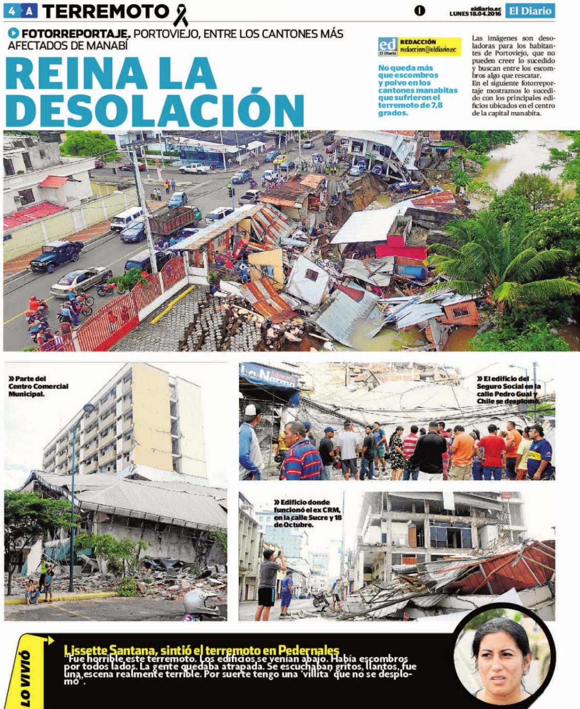
Figura 36. Edificaciones destruidas Reportaje del Diario Manabita. Reina la desolación. En las noticias se muestran edificaciones dentro de las calles Pedro Gual, 18 de Octubre y Sucre. Referencia http://ediciones.eldiario.ec/edicion_impresa/impreso/1118/
