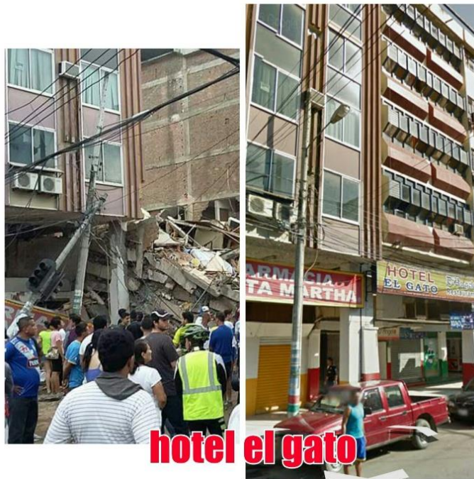
Figura 53. Edificio de Máximo Hidalgo, Hotel el Gato antes y después del Terremoto Ubicado en la calle Pedro Gual entre calle Olmedo y calle Morales. Referencia Vinces (2016)
