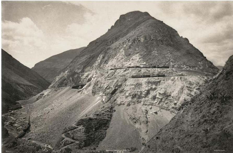
Switch Back on Pistichi. G⇌Q. Alausí - Chimborazo – Ecuador (1901) Fotografía de John Horgan. (Fondo de fotografía patrimonial.)
