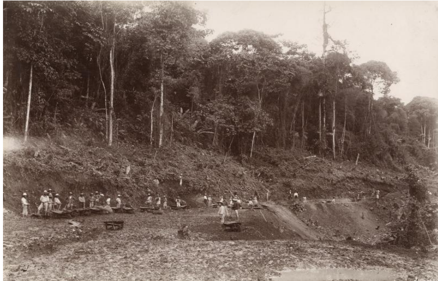
Construcción de la línea de ferrocarril en bosque de montaña en Ecuador, hacia los 1.500 msnm. - Ecuador (ca. 1899-1908) (Fondo de fotografía patrimonial.)
