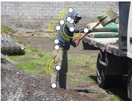
Figura 22. Postura de bodeguero para la carga y descarga de arena, ripio y otros materiales. Fuente: Elaboración propia.
