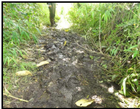
Figura 3: Erosión en senderos del RVSP
