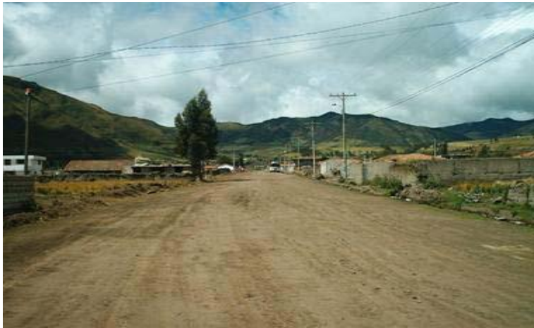
Fotografía 2.- Vista panorámica de un tramo de la carretera que conduce a la Comunidad La Chimba, desde Pesillo.
