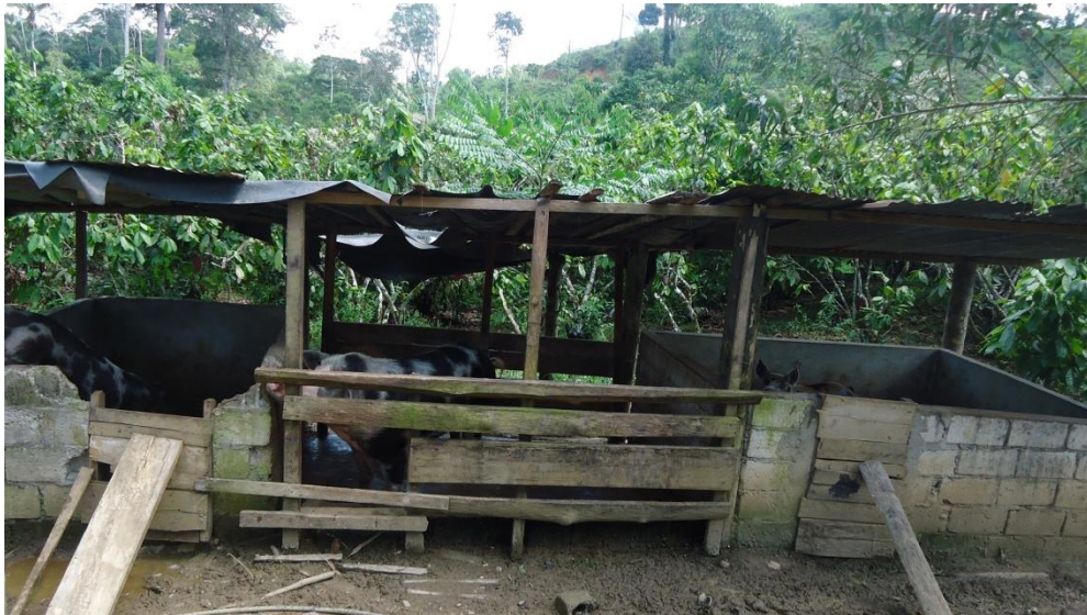
Fotografía N° 4. Infraestructura rústica para crianza de cerdos, comunidad El Oro.
