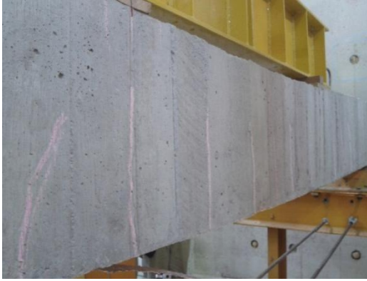
Foto 68 Control de carga y deformación
