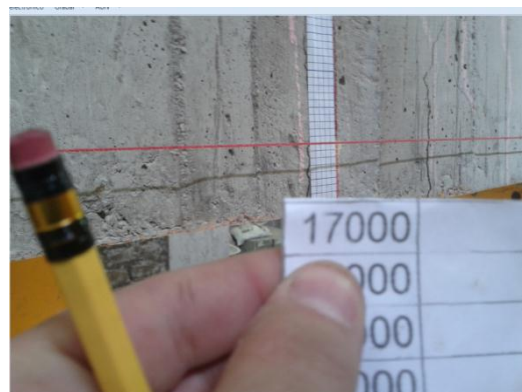
Foto 47 Control de carga y deformación
