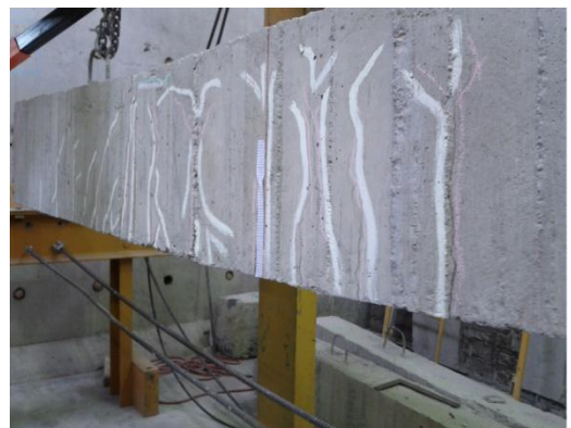
Foto 51 Grietas en cara frontal de viga
