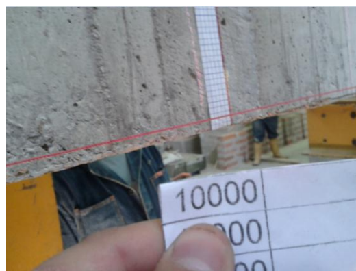
Foto 41 Control de carga y deformación
