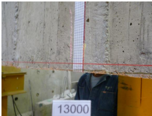
Foto 28 Control de carga y deformación
