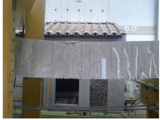
Foto 35 Grietas en cara frontal de viga
