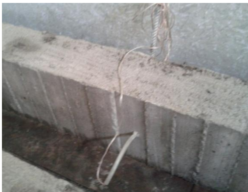
Foto 54 Viga HAREFC 4 fundida incorporado strain gage
