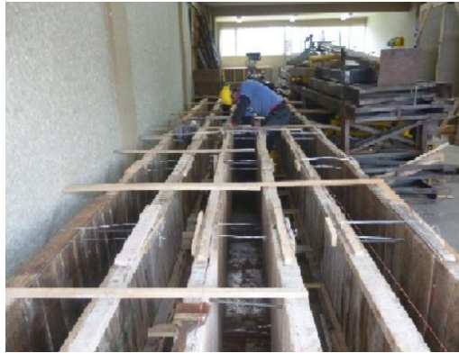
Foto 1 Preparación de encofrados
