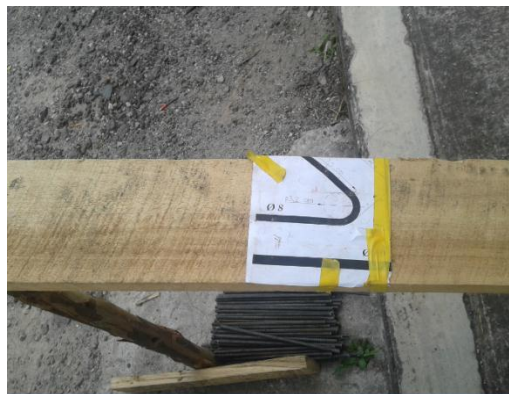
Foto 2 Preparación de estribos
