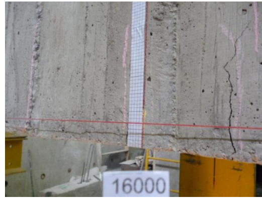
Foto 30 Control de carga y deformación
