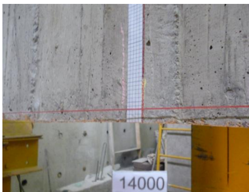
Foto 29 Control de carga y deformación
