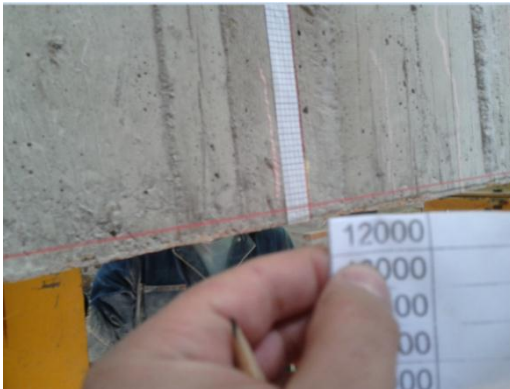
Foto 43 Control de carga y deformación
