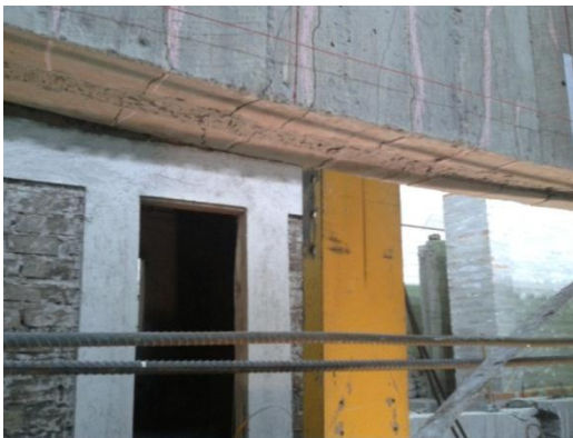
Foto 69 Desprendimiento de fibra de carbono
