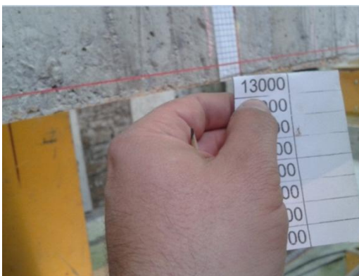
Foto 44 Control de carga y deformación
