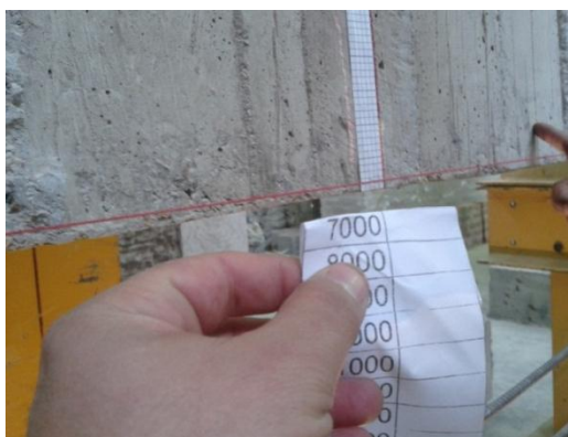
Foto 38 Control de carga y deformación
