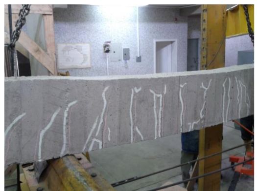
Foto 52 Grietas en cara posterior de viga
