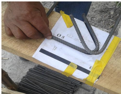
Foto 3 Preparación de estribos
