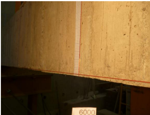
Foto 22 Control de carga y deformación
