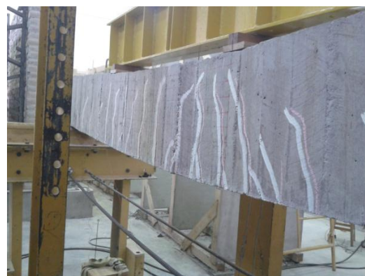
Foto 33 Grietas en cara posterior de viga
