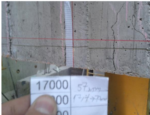
Foto 49 Control de carga y deformación
