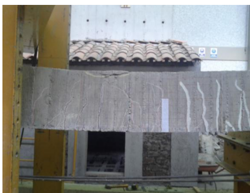
Foto 76 Grietas producidas en vigas
