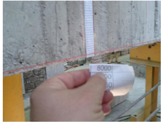
Foto 39 Control de carga y deformación
