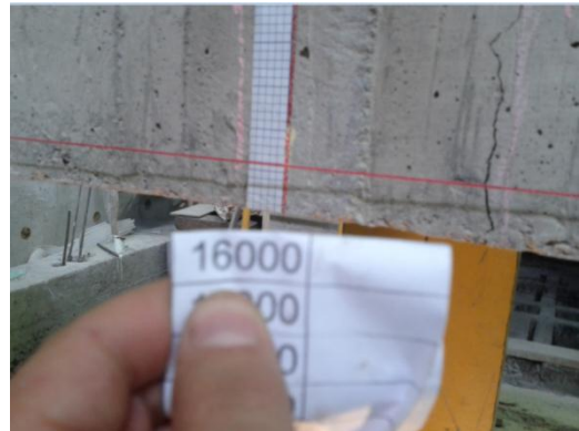
Foto 46 Control de carga y deformación
