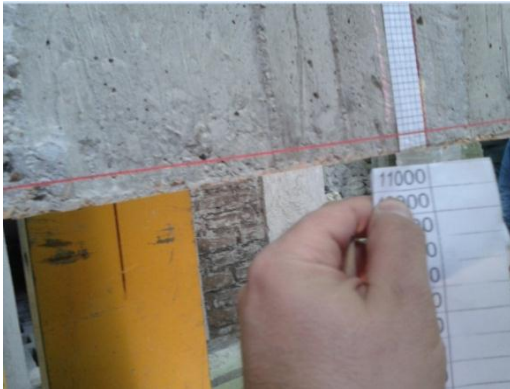
Foto 42 Control de carga y deformación
