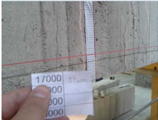
Foto 48 Control de carga y deformación
