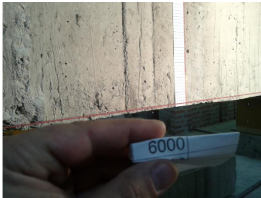
Foto 37 Control de carga y deformación
