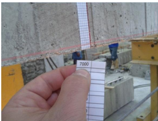
Foto 58 Control de carga y deformación
