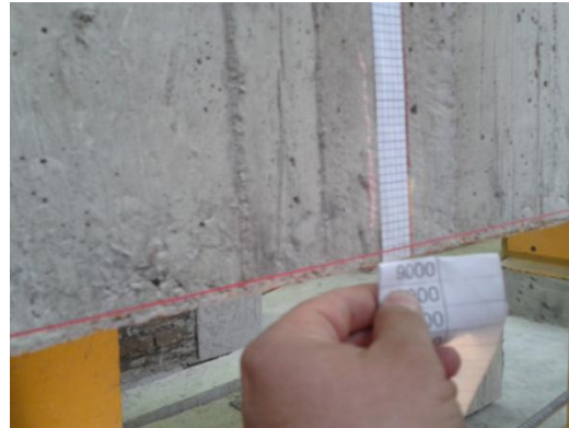
Foto 40 Control de carga y deformación
