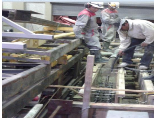
Foto 5 Compactación de vigas
