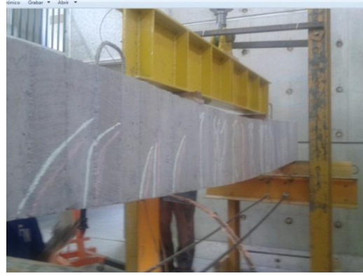
Foto 71 Estado de fisuras
