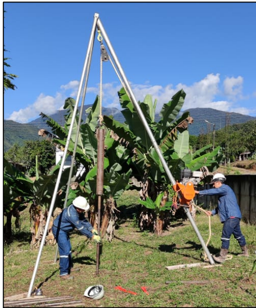
Fotografía 1. Ejecución de ensayo SPT
