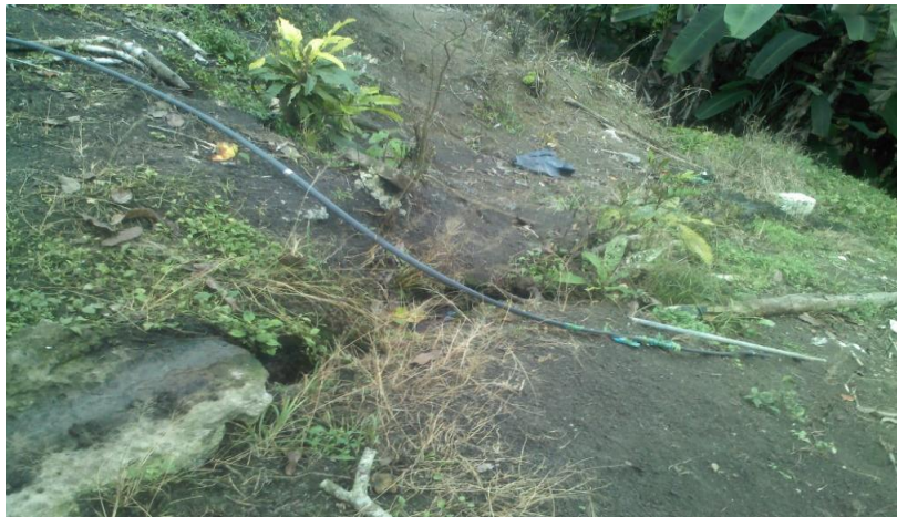
Fotografía 8. Infiltración del agua residual.
