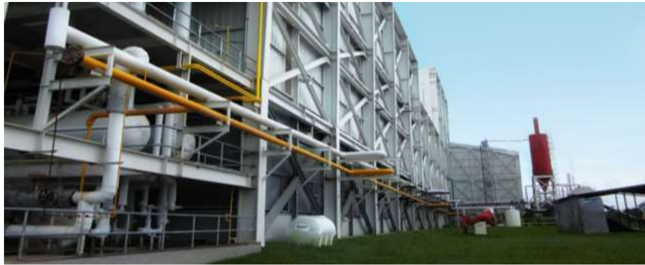
Figura 17 Vista exterior estructura metálica Fuente: (BAQ, 2016)
