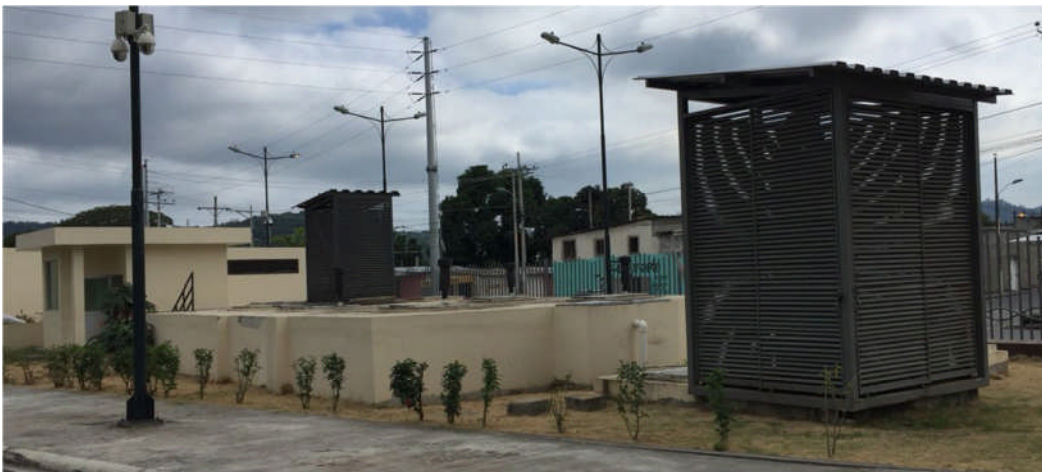
Ilustración 9 Planta de tratamiento de aguas residuales del hospital
