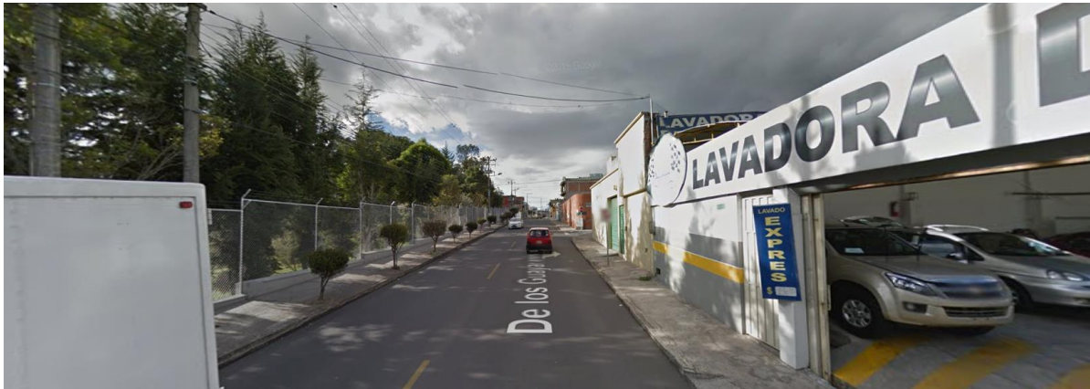
Fuente: (Street View, 2014)
