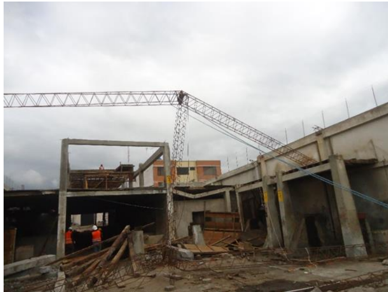
Figura 24: Técnica de tracción con medios manuales. Fuente: foto tomada el 30 de noviembre de 2016 (Cabezas, I.)
