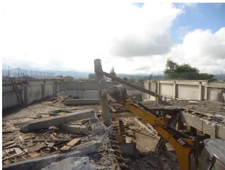
Figura 23: Técnica de empuje con medio mecánico. Fuente: foto tomada el 2 de diciembre de 2016 (Cabezas, I.)
