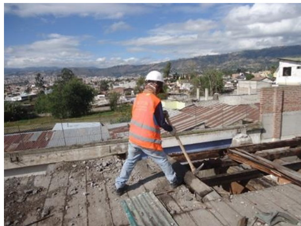
Figura 36: Desmontaje manual de elementos de entrepiso según el método de arriba hacia abajo. Fuente: foto tomada el 23 de noviembre de 2016 (Cabezas, I.)
