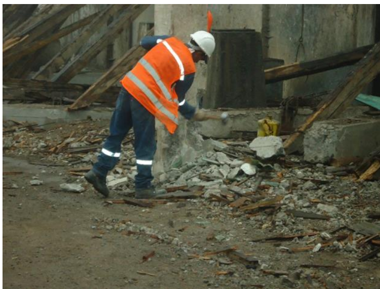
Figura 26: Técnica de impacto con medio manual. Fuente: foto tomada el 2 de diciembre de 2016 (Cabezas, I.)
