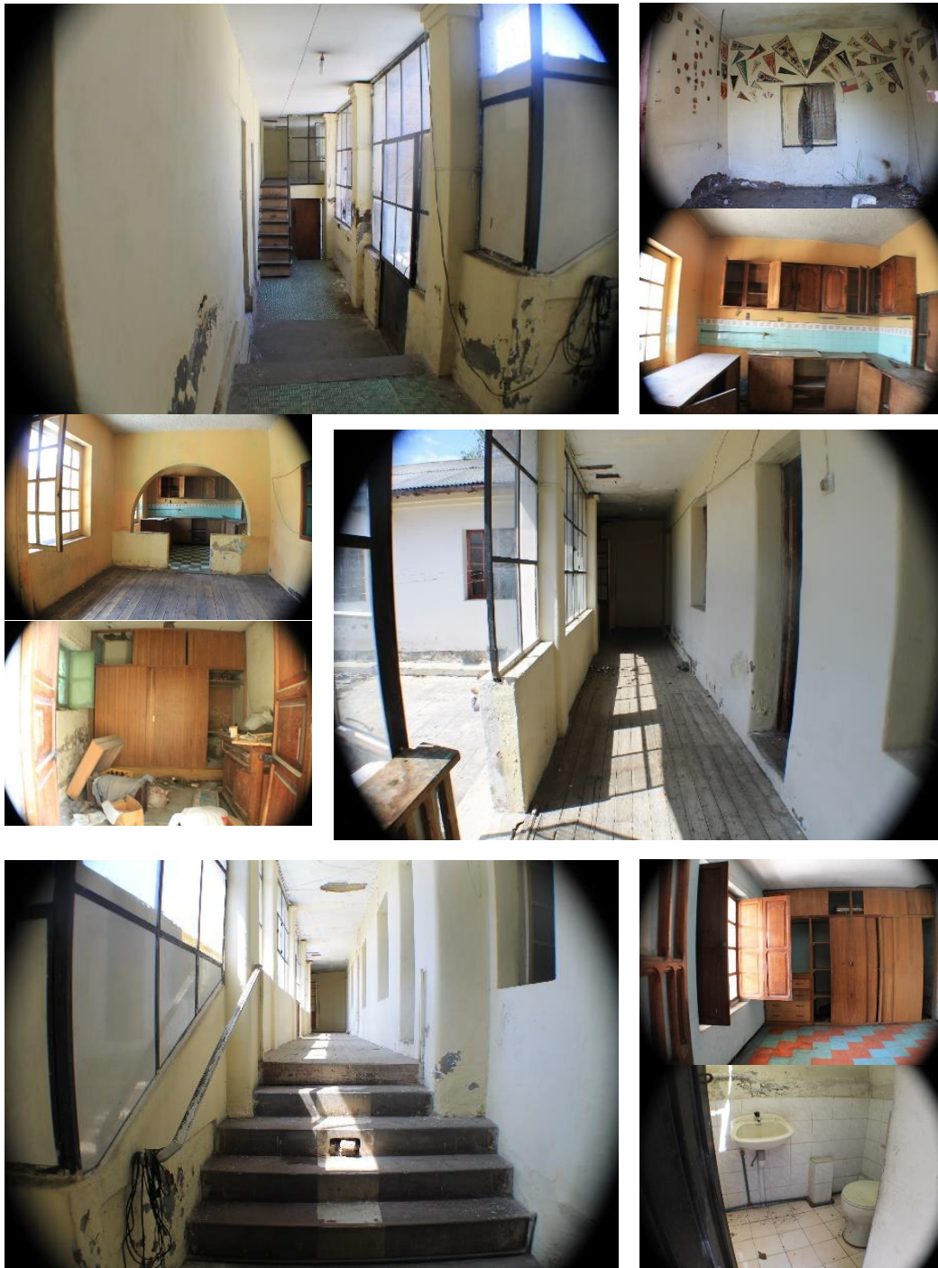
Figura 65: Vistas interiores del inmueble existente. Fuente: fotos tomadas en abril de 2017 (Cabezas I., 2017)
