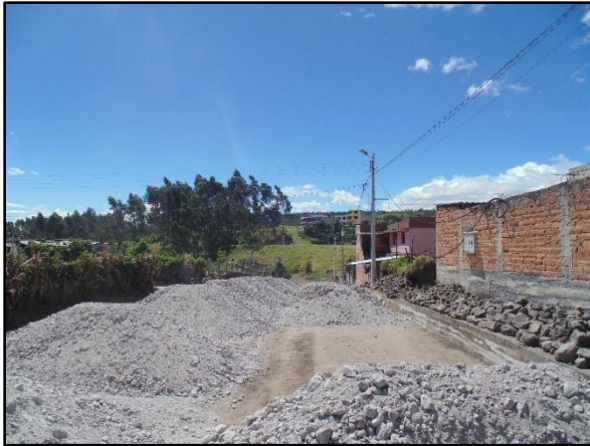
Fotografía 4. Obras de alcantarillado calle D
