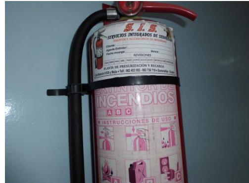
Extintores sin recargar y caducados
