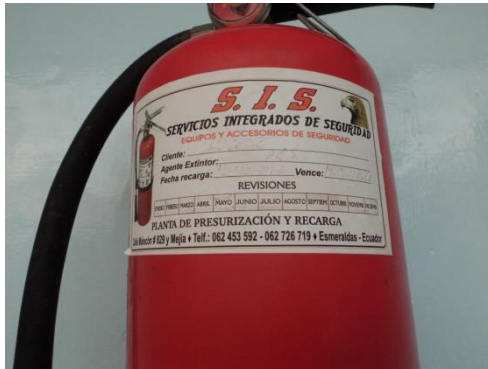
Extintores sin recargar y caducados
