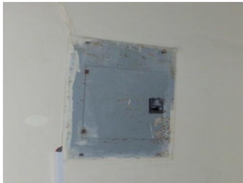
Cajas de breque sin señalización
