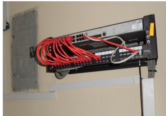
Cajas de breque sin señalización
