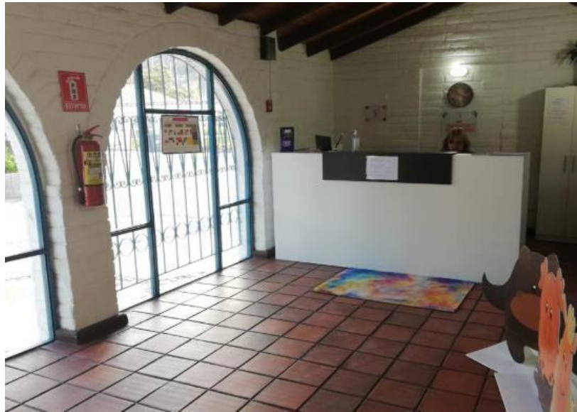
Figura.4. Altura de Extintor
