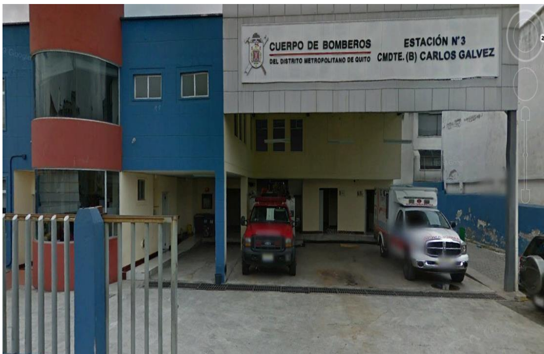
Figura 15. Vista Frontal de la Estación de Bomberos Nro. 3. Comandante Carlos Gálvez
