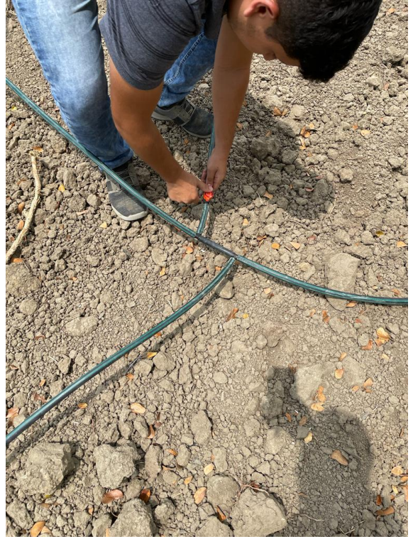
Imagen 2 Colocación de las válvulas
