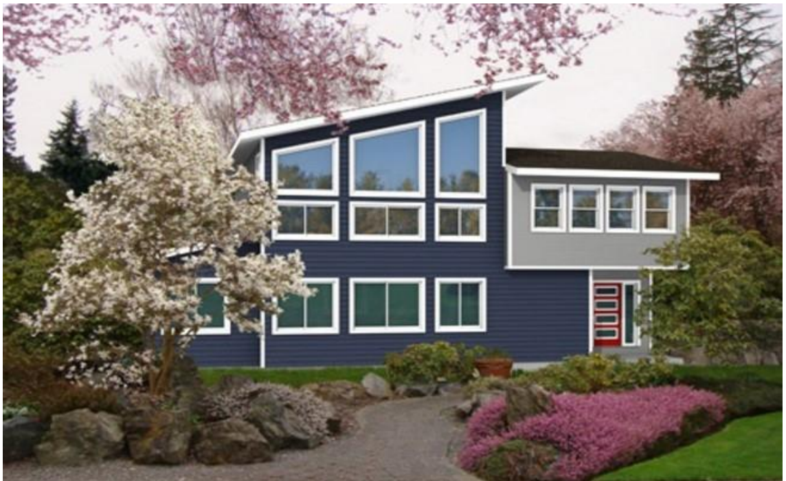
Figura 10 Fachada de la casa considerada para la red óptica del hogar del futuro
