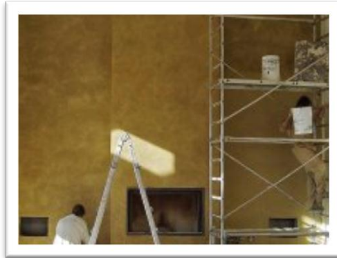
Imagen: 28 Revestimiento de Estuco Veneciano
