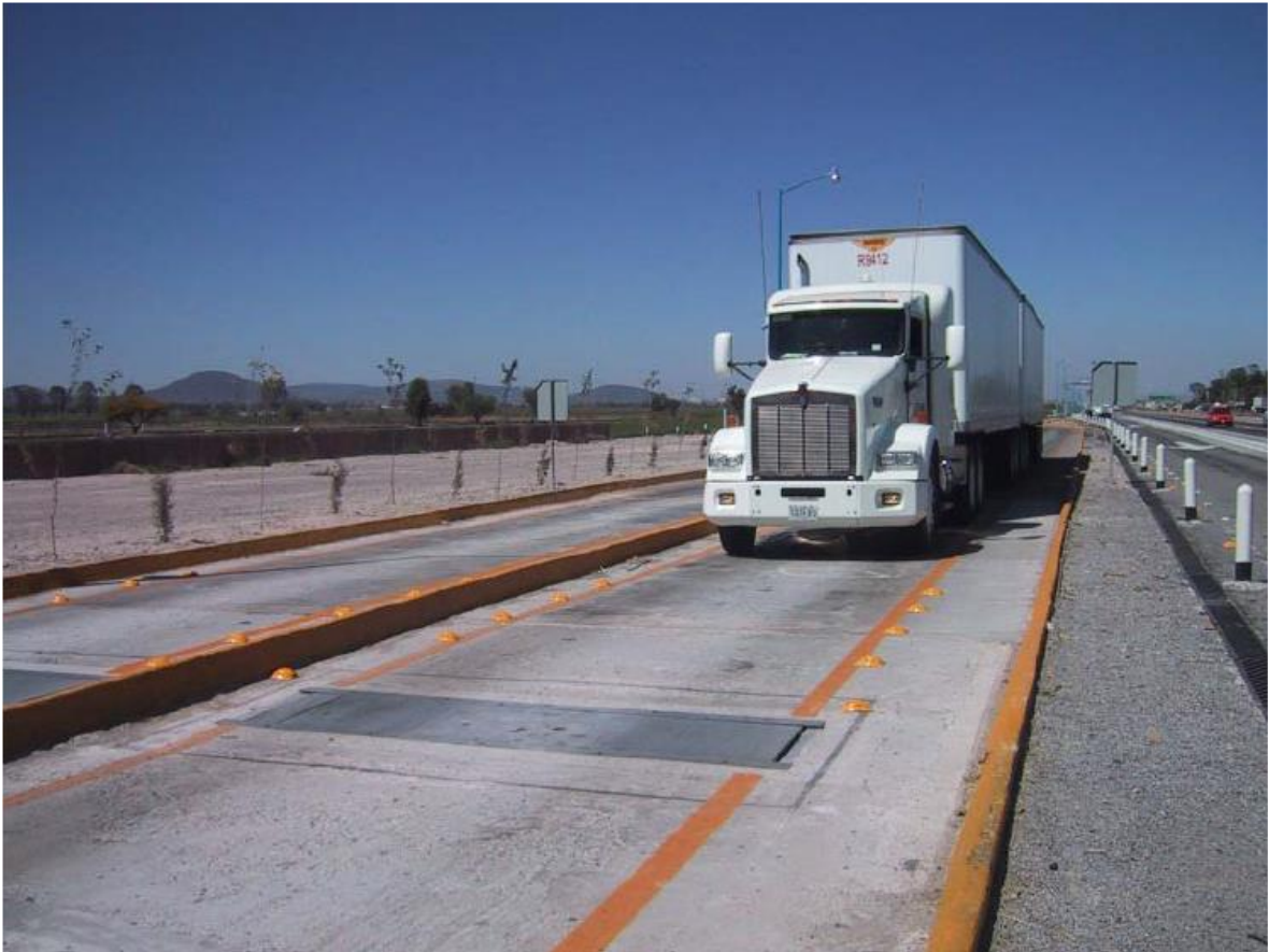
Gráfico 3. 1 Báscula Fija para Pesaje
