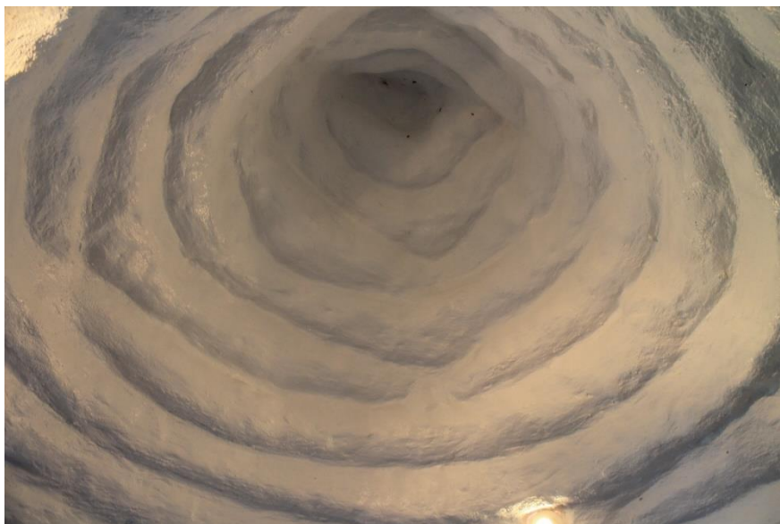
Fotografía 14: Remate de cubierta en super adobe Elaboración: Dayanna Chávez (FADA-PUCE), Laboratorio de los Paisajes Vivos, 2017-2018
