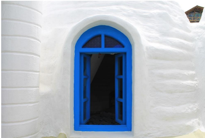
Fotografía 12: Ventana en superadobe Elaboración: Dayanna Chávez (FADA-PUCE), Laboratorio de los Paisajes Vivos, 2017-2018
