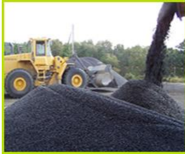
Figura 4.- Elaboración de asfalto en frío en una central fija.
