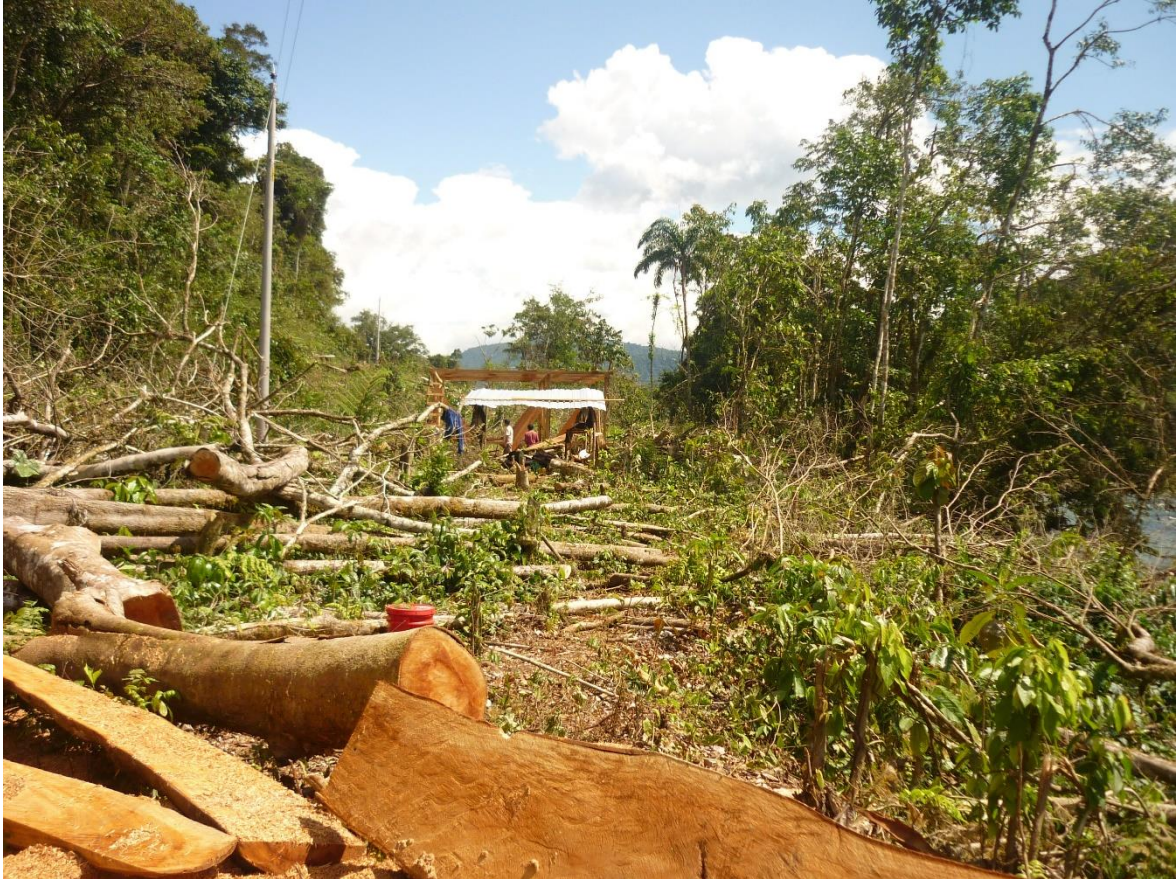
Figura 7: Apertura de bosque para construcción de choza mestiza.
