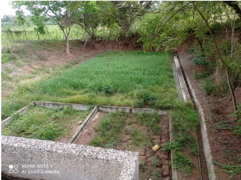
Foto 4. Lecho de secados y posible campo de infiltración
