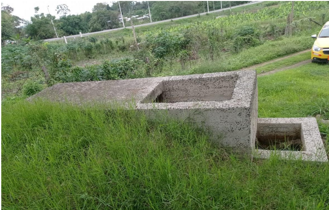
Foto 1. Estructura de llegada tipo cárcamo
