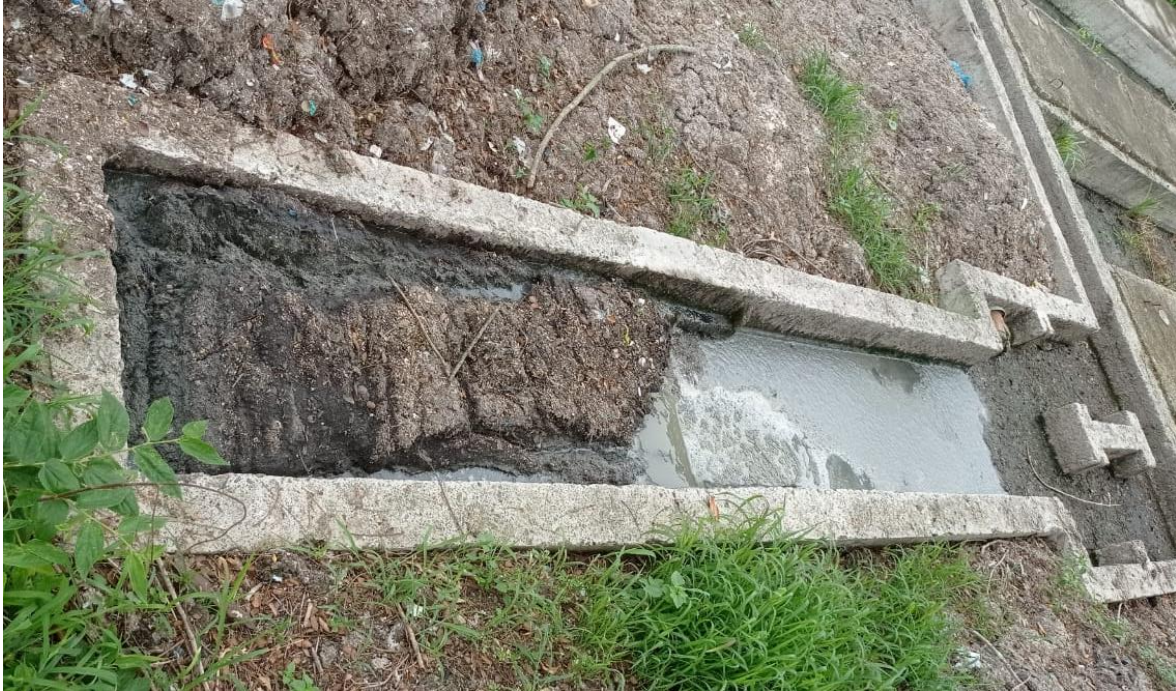
Imagen 2. Estructura de llegada, tipo “canal desarenador”
