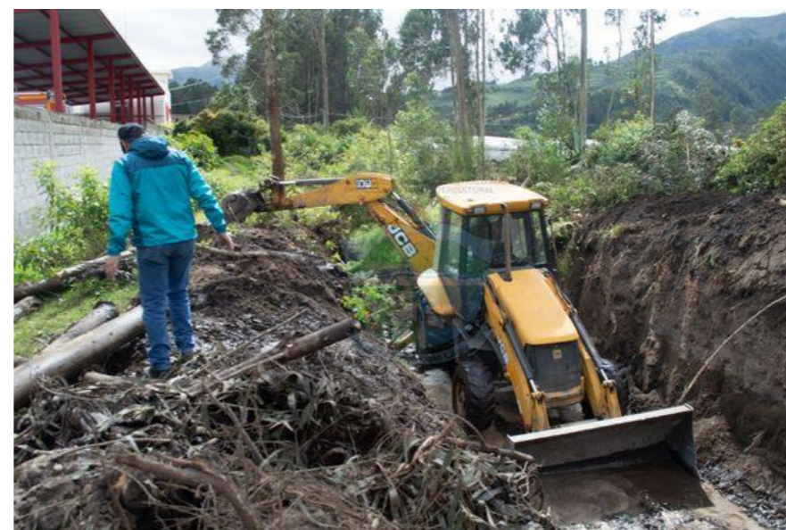
Ilustración 123: Limpieza de Quebrada Cusín Fuente: GAD San Pablo del Lago
