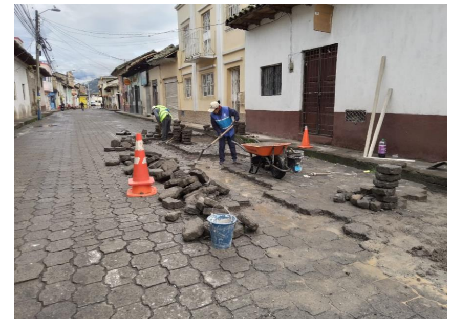
Ilustración 94: Trabajos en la vía calle Chiriboga Fuente: Quilumba Alexander
