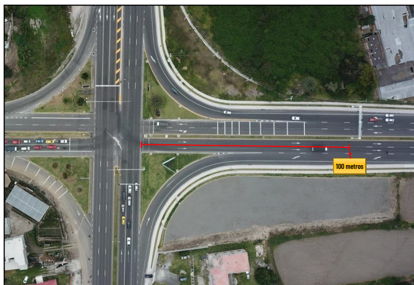
Imagen No. 4 - 11: Señalización en la calzada de 100m en el sentido S-N, Intersección Sur.
